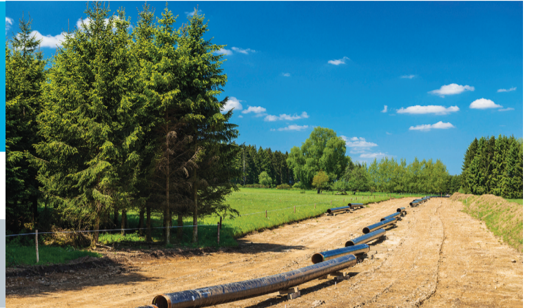
Un gazoduc en construction
