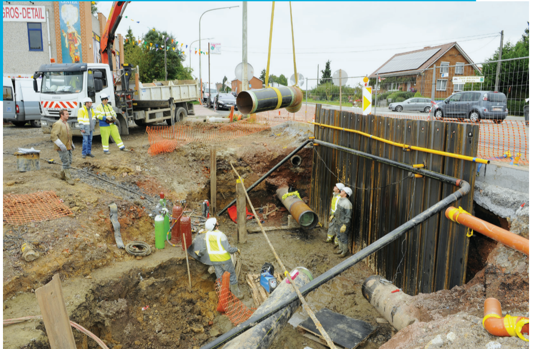
Les conduites de gaz sont enterrées dans le sous-sol.
