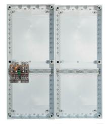
Lorsque l'intensité totale de l'ensemble de comptage est comprise entre 66 et 80 ampères, le coffret de droite doit être équipé d'un bloc de raccordement. Ce dernier est à placer dans le coin supérieur gauche du coffret.
