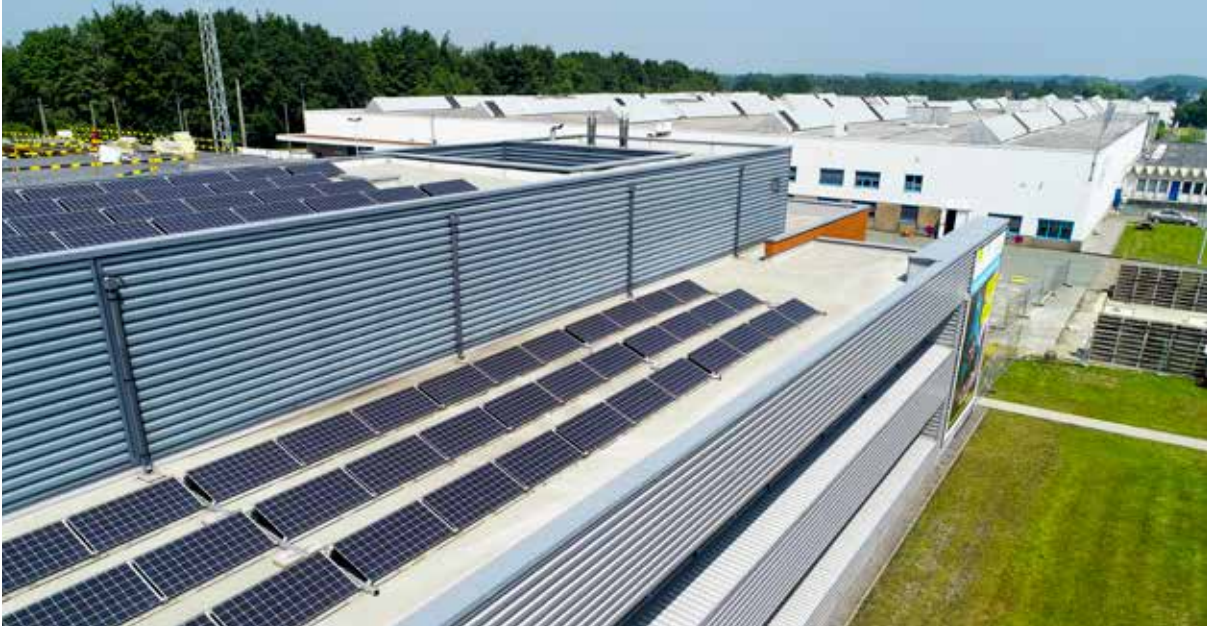
BÂTIMENT DU NOUVEAU CENTRE TECHNIQUE À STRÉPY-BRACQUEGNIES.
